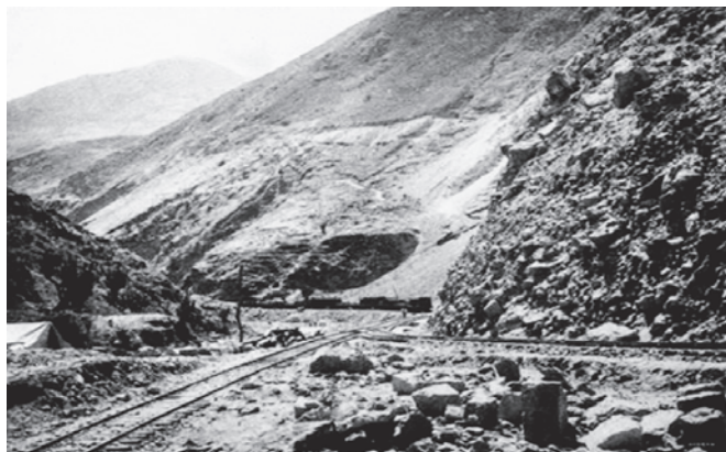
El sector de Colta, Chimborazo, durante la construcción del ferrocarril, Quito-Guayaquil, 1901
