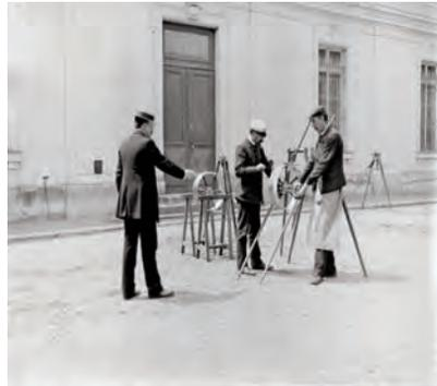
**Imagen 1: En las imágenes se puede ver la operación de calibración de los cables de Jadërin en invar realizada al principio y al final de la medida del arco al *Bureau International des poids et mesures* en París.**
