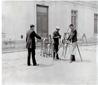
Imagen 1: En las imágenes se puede ver la operación de calibración de los cables de Jadërin en invar realizada al principio y al final de la medida del arco al Bureau International des poids et mesures en Paris.
