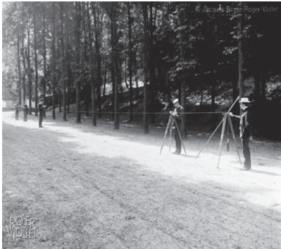
Imagen 1: En las imágenes se puede ver la operación de calibración de los cables de Jadërin en invar realizada al principio y al final de la medida del arco al Bureau International des poids et mesures en Paris.
